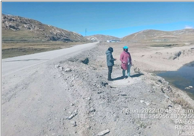
Fotografía 3: Buzon de desagüe, peligro de erosion de ribera y plataforma carretera.
